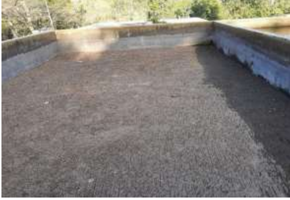
चित्र 29: चोक धीमी रेत फिल्टर
